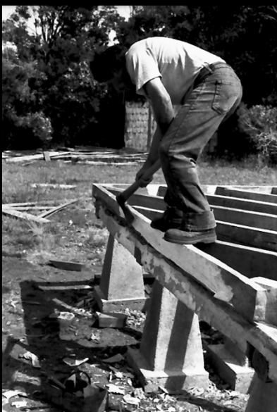
Tito Soto en faena de envigado; nueva Iglesia San José de Butachauques (2003-2004)
