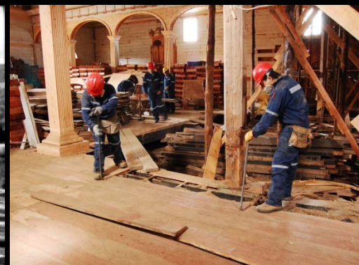
Restauración Iglesia de Colo, PDST, 2009
